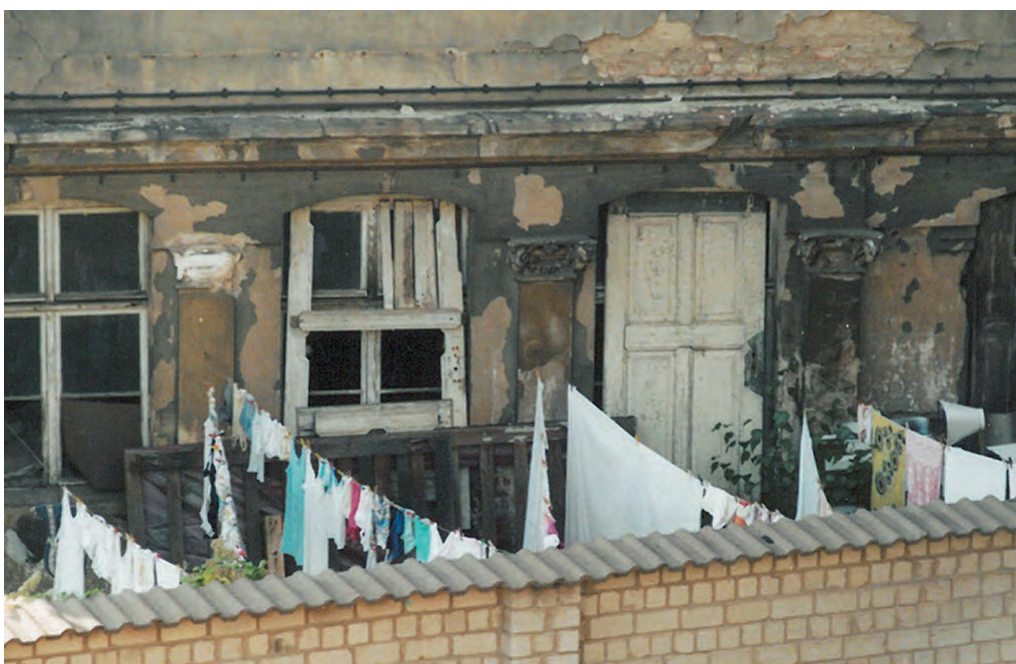
15 Pilaster und Kapitelle des überbauten Gartenpavillons auf dem Grundstück Benkertstraße 16 Zustand 1991
