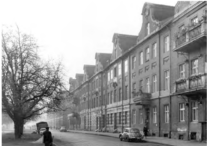
13 Straße Am Bassin, Blick in Richtung Nikolaikirche um 1970
